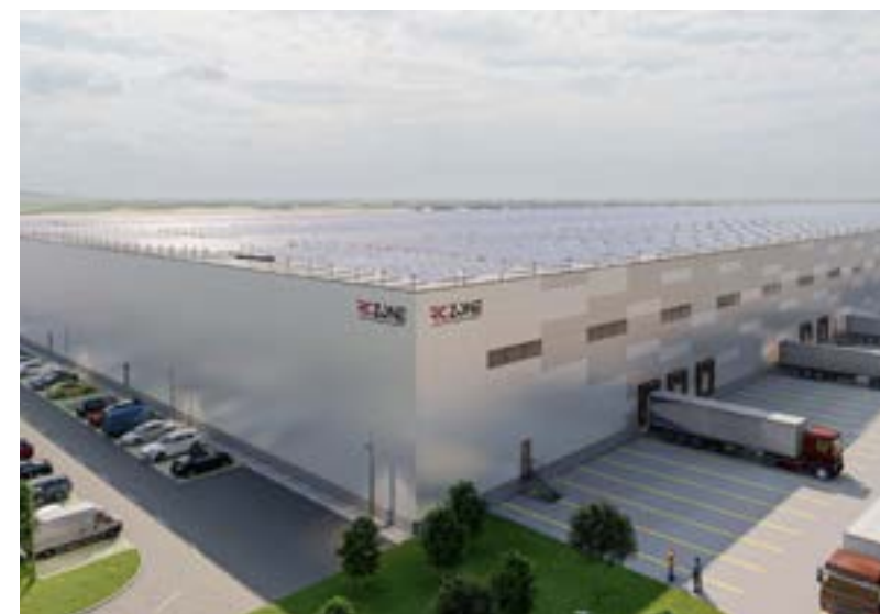
Centrum logistyczne RC Zone Samobor w Chorwacji – wyposażone w systemy klimatyzacji Hoval i oprogramowanie HovalSupervisor cloud
