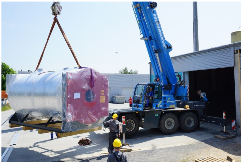
Bild 2: Ankunft des neuen Erdgaskessels mit fünf MW Leistung in Kamenz.
